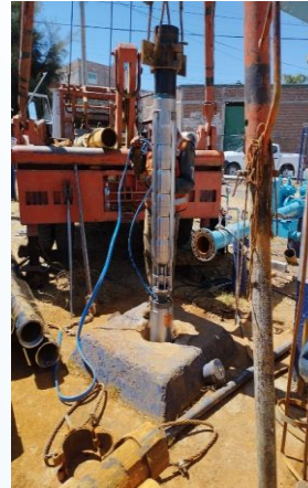
Adquisición de motor sumergible nuevo marca Altamira 100 Hp, 460 V, Bomba sumergible Altamira KOR40 R1000-5-1.
