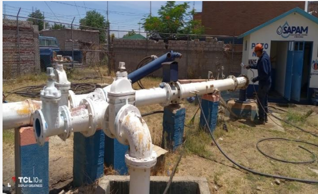
Imagen antes de la limpieza al pozo.
