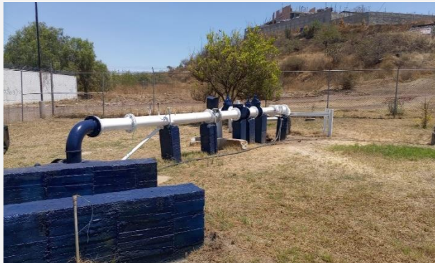
Imagen después del mantenimiento al pozo.
